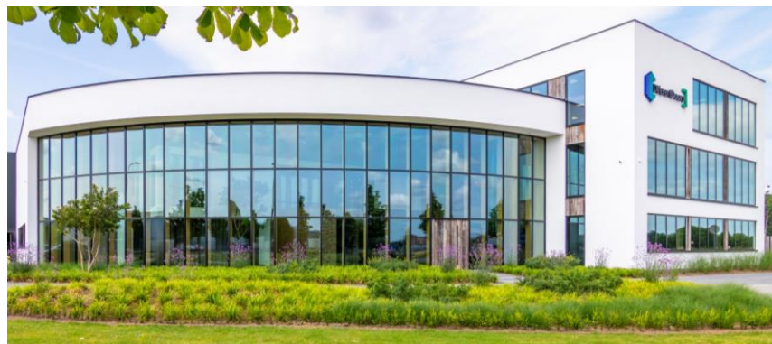
Bedrijfsgebouw dat voldoet aan de eis van 2050 te Budel
