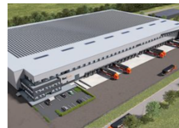
Start bouw duurzaam distributiecentrum Vos Logistics in Oss
